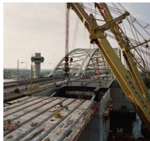
Klep invaren bij de de Van Brienoordbrug (1989)
