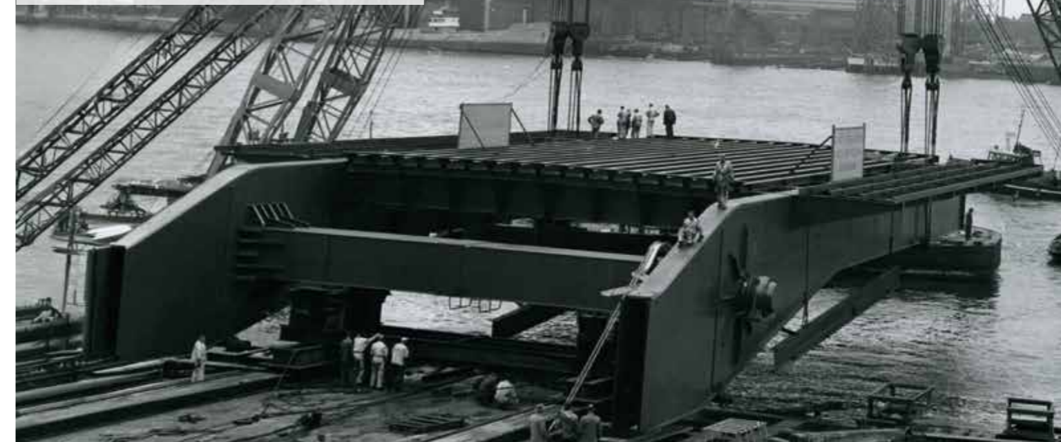
Begin bouw Merwedebrug 1960
