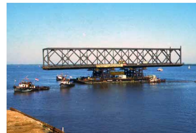
Uitvaren brugsegment Moerdijkbrug (1977)
