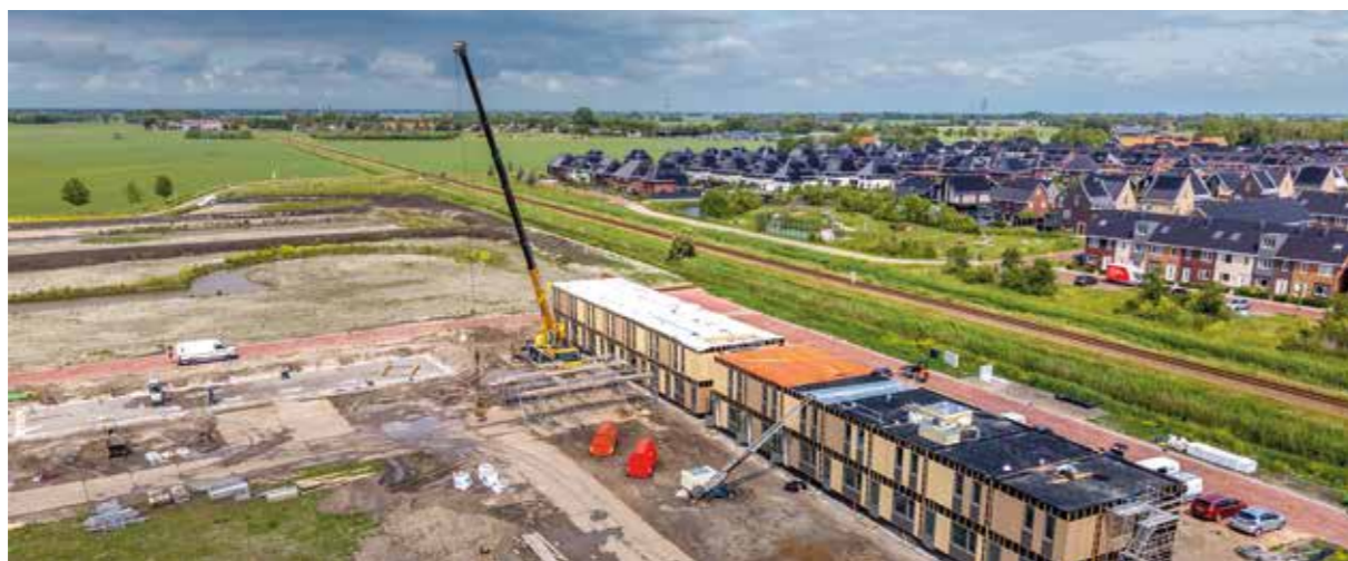
modulaire bouwplaats Sneek
