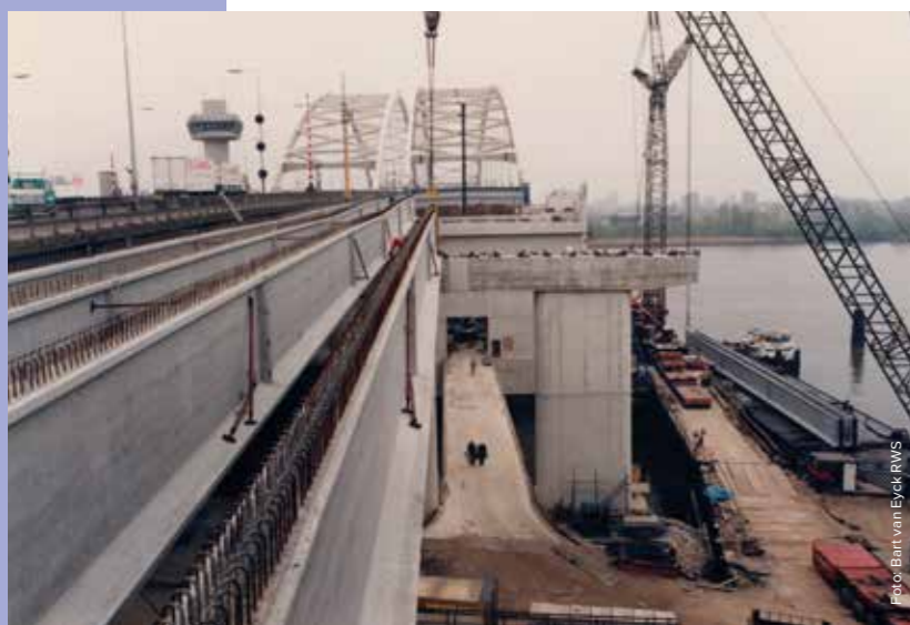
Aanleg van BrienoordbrugII (1989)
